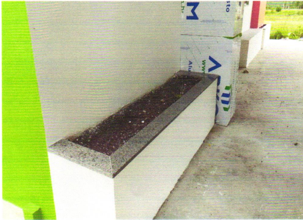
Foto 07– Fornecimento e espalhamento de terra vegetal preparada
