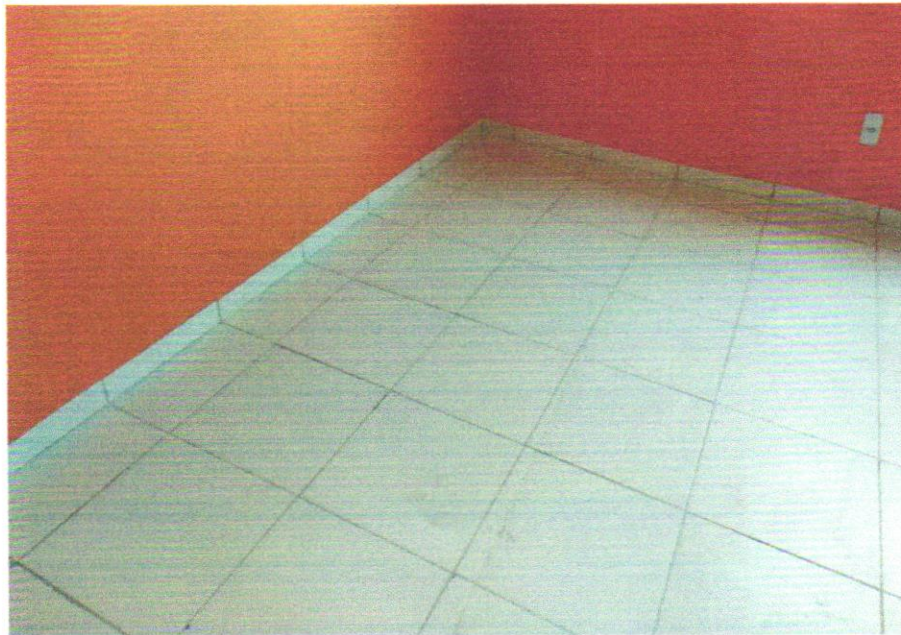
Foto 15 - RODAPÉ CERÂMICO DE 7CM DE ALTURA COM PLACAS TIPO ESMALTADA EXTRA DE DIMENSÕES 45X45CM. AF_06/2014
