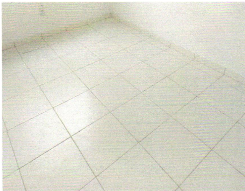
Foto 16 - RODAPÉ CERÂMICO DE 7CM DE ALTURA COM PLACAS TIPO ESMALTADA EXTRA DE DIMENSÕES 45X45CM. AF_06/2014
