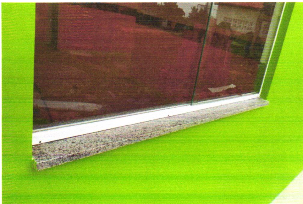
Foto 20 - PEITORIL LINEAR EM GRANITO OU MÁRMORE, L = 15CM, COMPRIMENTO DE ATÉ 2M, ASSENTADO COM ARGAMASSA 1:6 COM ADITIVO. AF_11/2020
