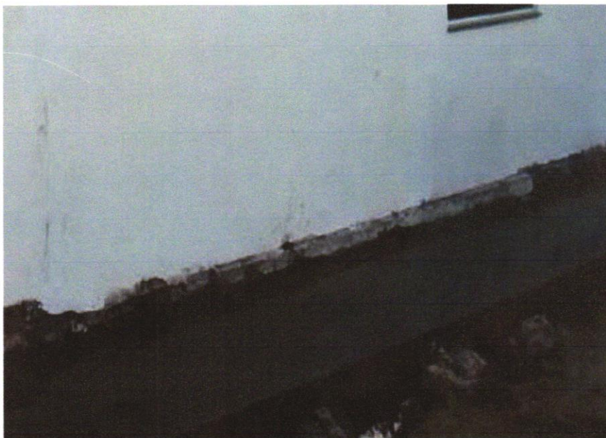
Foto 39- EXECUÇÃO DE PASSEIO (CALÇADA) OU PISO DE CONCRETO COM CONCRETO MOLDADO IN LOCO, FEITO EM OBRA, ACABAMENTO CONVENCIONAL, ESPESSURA 8 CM, ARMADO. AF_07/2016
