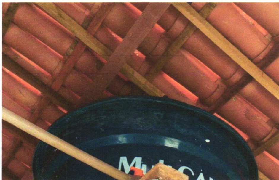
Foto 37- CAIXA D'ÁGUA EM POLIÉSTER REFORÇADO COM FIBRA DE VIDRO, 500 LITROS - FORNECIMENTO E INSTALAÇÃO. AF_06/2021 e REGISTRO DE ESFERA, PVC, SOLDÁVEL, COM VOLANTE, DN 25 MM - FORNECIMENTO E INSTALAÇÃO. AF_08/2021
