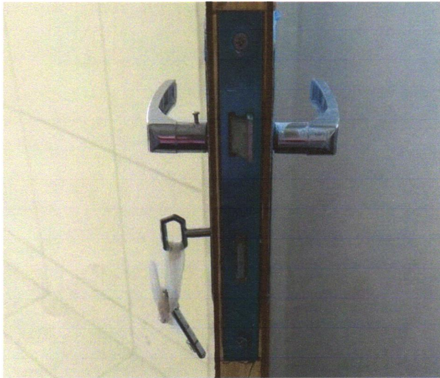
Foto 35 - Fechadura para portas interna/externas, IMAB, linha Duna, ref.8866-CR, ou similar
