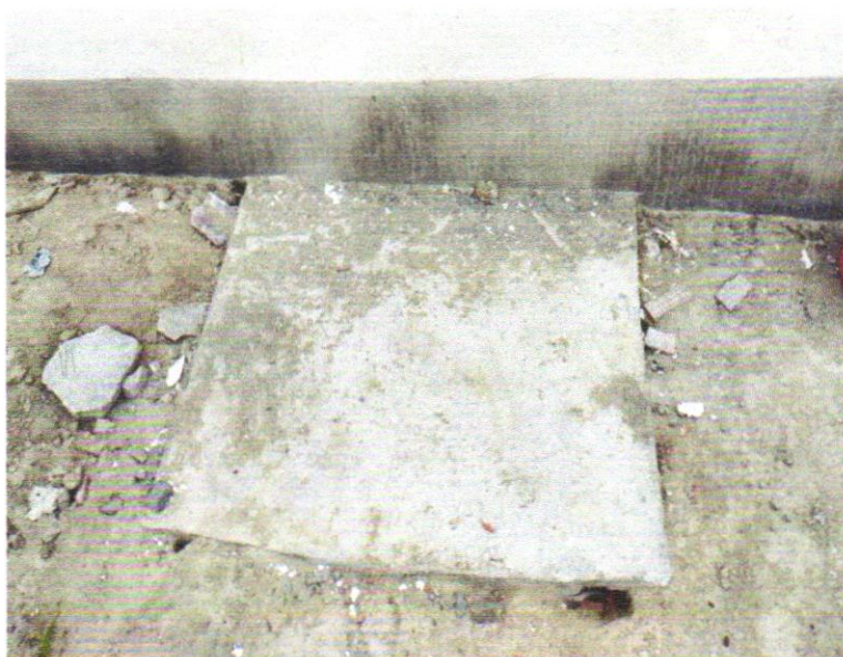
Foto 18 – Fossa séptica pré-moldada, tipo oms, capacidade 15 pessoas (v=900 litros)
