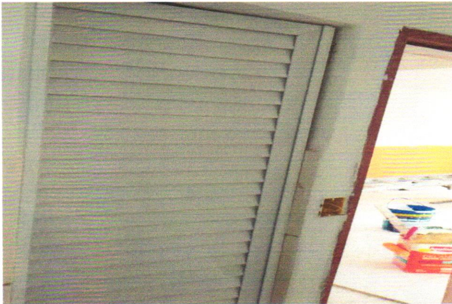
Foto 13 PORTA EM ALUMÍNIO DE ABRIR TIPO VENEZIANA COM GUARNIÇÃO, FIXAÇÃO COM PARAFUSOS - FORNECIMENTO E INSTALAÇÃO. AF_12/2019
