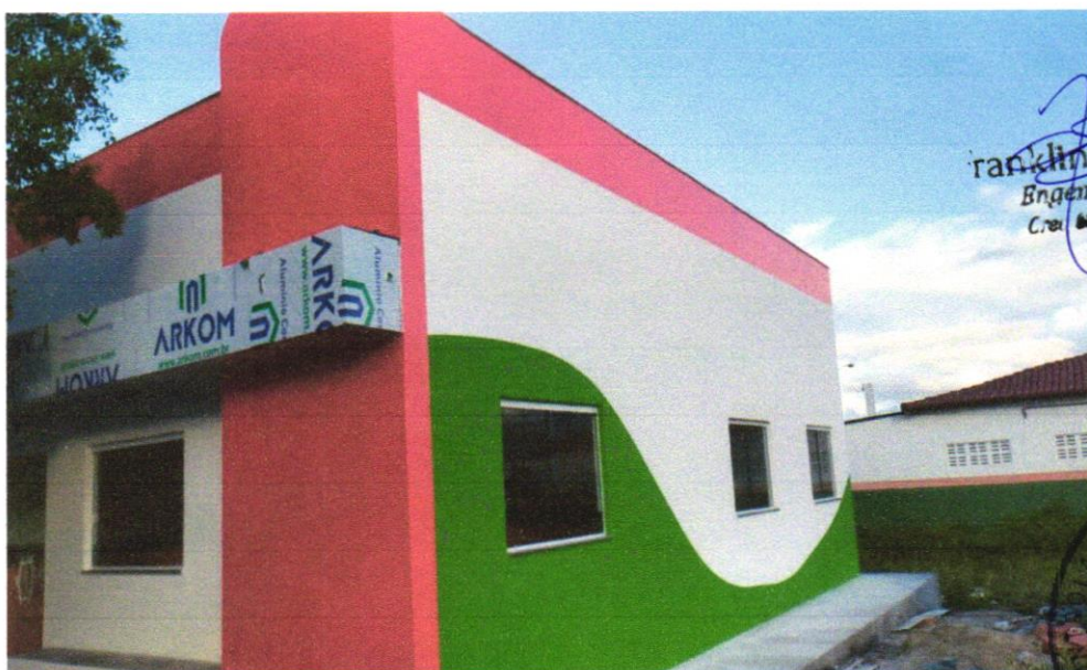
FOTO 02 – revestimento metálico em alumínio composto (Alucobond), e=0,3mm, pintura Kaynar 500 composta por seis
