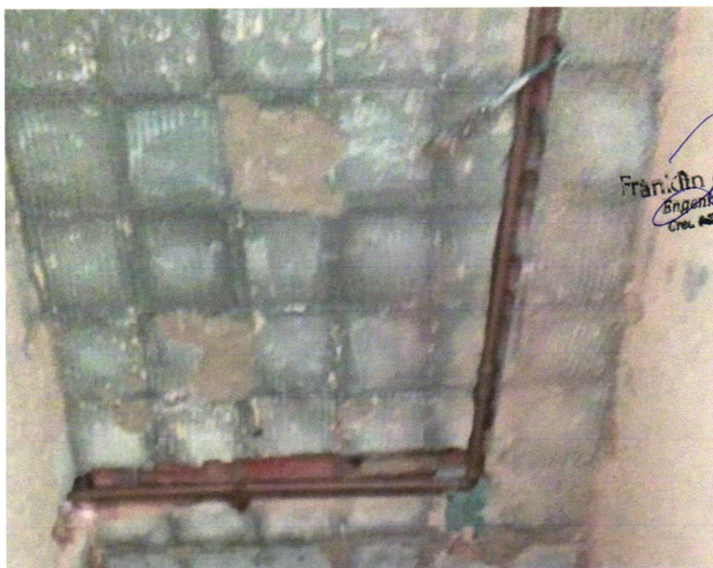
Foto 28 – TUBO, PVC, SOLDÁVEL, DN 25MM, INSTALADO EM RAMAL OU SUB-RAMAL DE ÁGUA - FORNECIMENTO E INSTALAÇÃO. AF_06/2022
