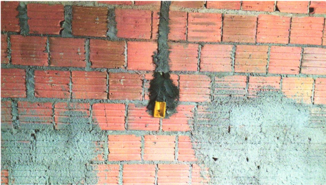
FOTO 33 - Alvenaria de vedação de blocos
